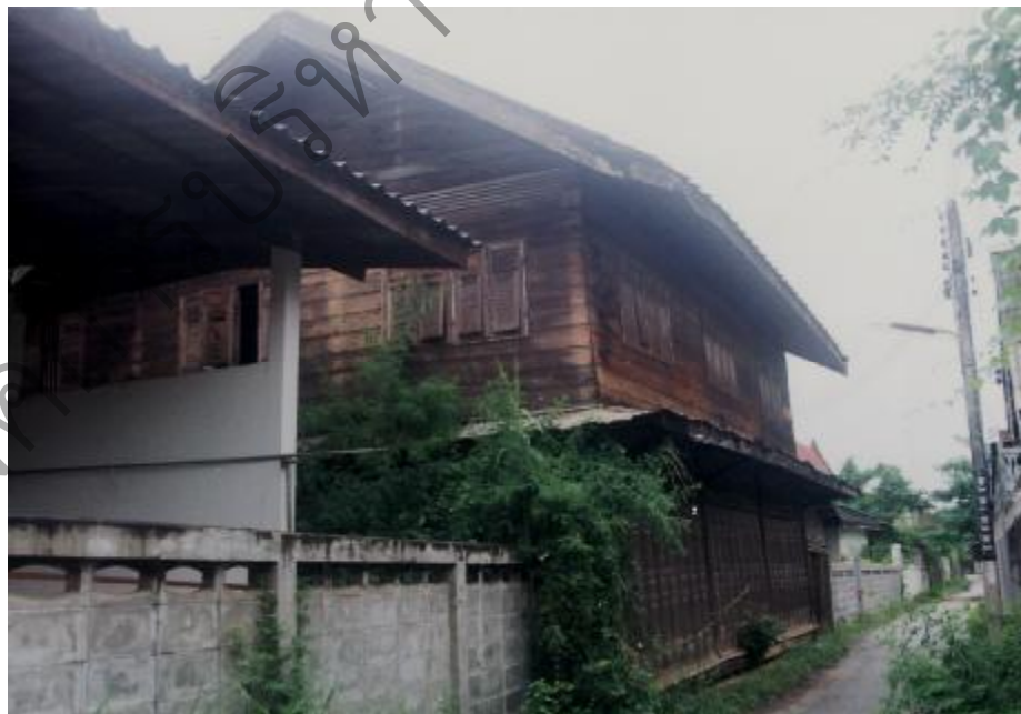
ภาพที่ ๑๓.๒๕ บ้านวัชรพุกก์หลังนี้ เดิมก็อยู่ติดริมแม่น้ำปิง ใช้ประกอบการค้าขายเครื่องเขียนแบบเรียน ของนางบุญมี วัชรพุกก์ ประตูหน้าบ้าน จึงเป็นแบบบานเฟี้ยมทั้งหมด หลังบ้านจะยื่นไปในแม่น้ำ
